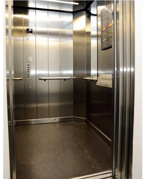
Lift vom Foyer in die Neue Galerie
