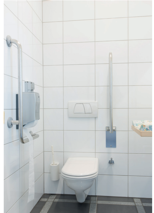
Barrierefreies WC Erdgeschoss
