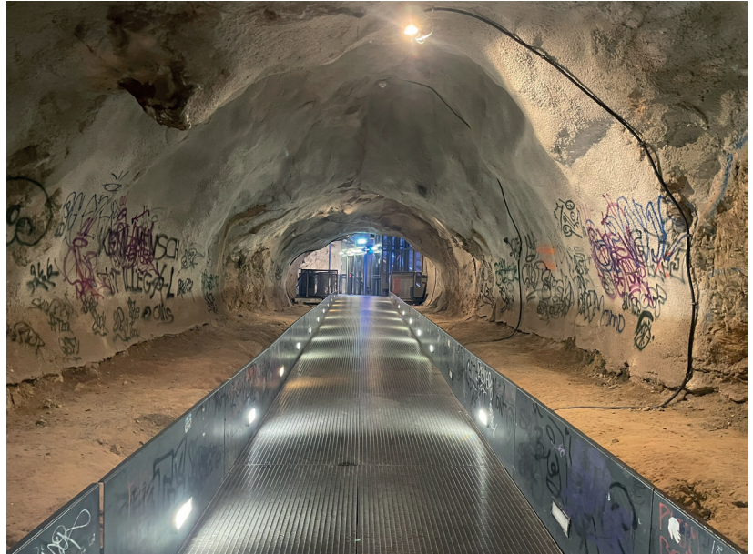
Rampe vom Lift zum Dom im Berg
